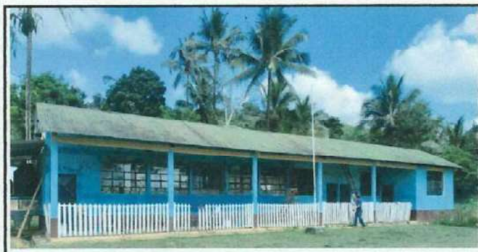
Foto 5: cubierta de lamina del techo de toda la escuela.
